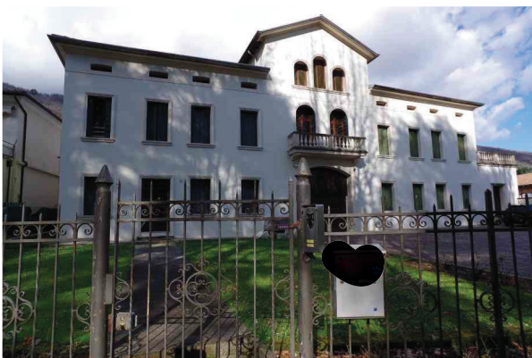
5. Vista ingresso pedonale, civico 21.
